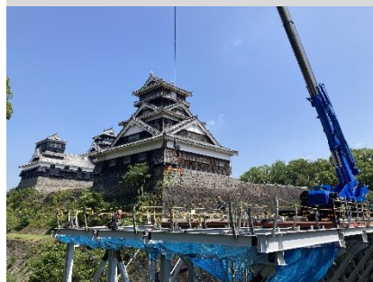
宇土櫓（復旧工事中）
