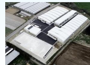
熊本市東部堆肥センター
