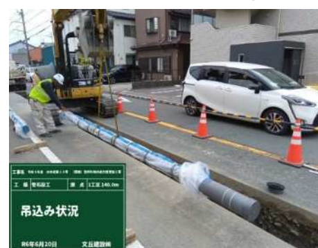
老朽管更新工事（φ150mm）
