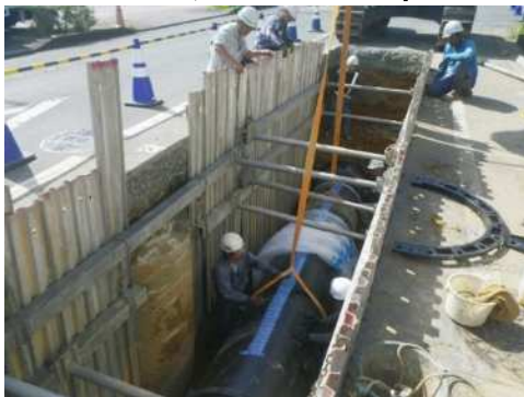
基幹管路耐震化工事（φ900mm）
