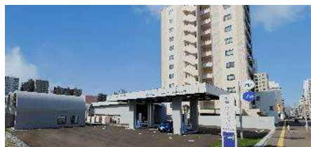
▲水素ステーション
