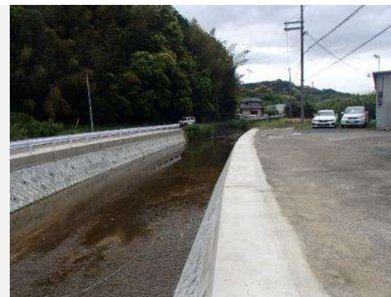
河川修繕・堤防改修事業
