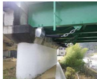
落橋防止の設置
