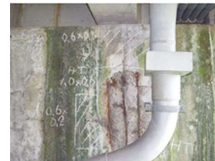
コンクリートの剥離（橋脚）の補修
