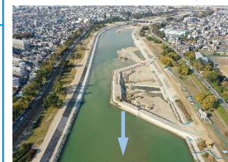
武庫川 河川改修(1号床止撤去)
