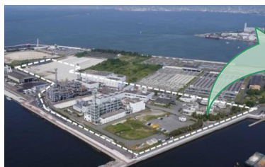
兵庫東流域下水汚泥広域処理場
