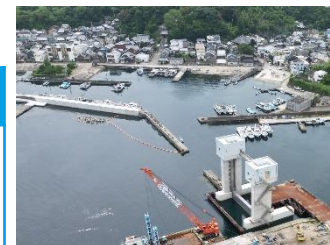
沼島漁港 津波対策(水門等整備)
