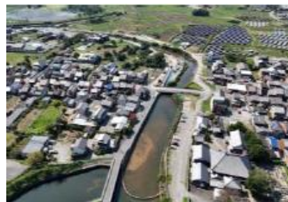
護岸改修事業
