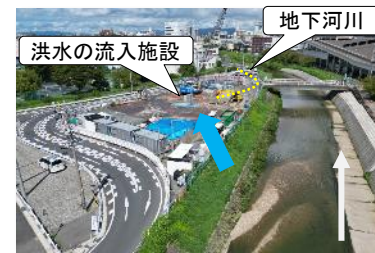
河川海岸整備
