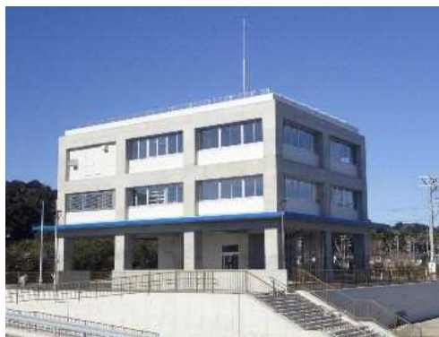
県有建築物のZEB化
