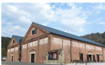
敦賀赤レンガ倉庫
