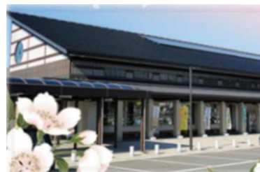
道の駅における太陽光発電設備等の導入による防災力強化 (写真:道の駅織姫の里なかのと)
