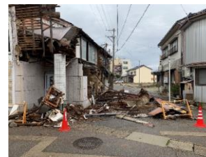
倒壊した家屋（氷見市）
