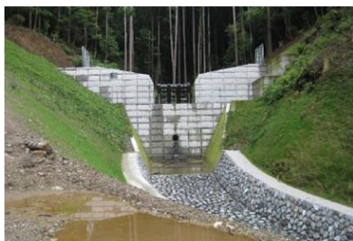
砂防関係施設整備
