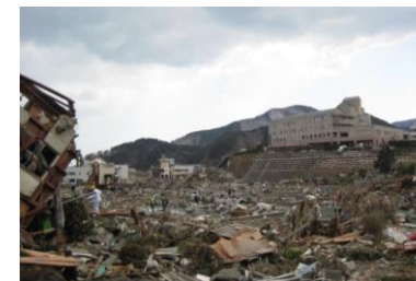
女川町の被害状況
