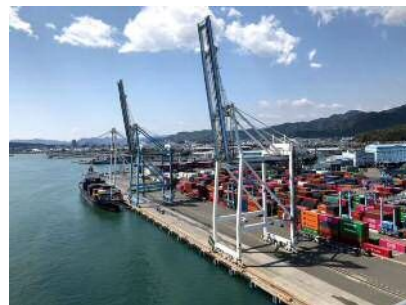
清水港での荷役の様子
