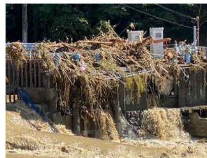
承元寺取水口への流木等流入
