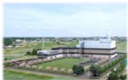
サーマルエネルギーセンター
