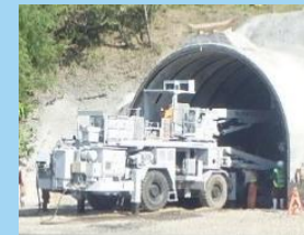
札幌トンネル(星置工区)
