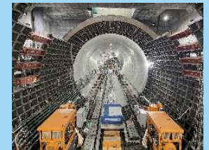
札幌トンネル(札幌工区)
