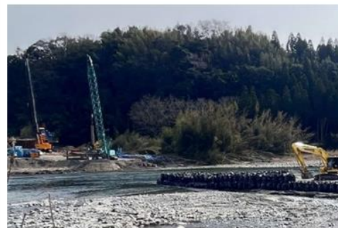
「球磨川第4橋梁」建設工事状況
