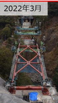
第一白川橋梁架橋の様子
