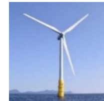
2MW浮体式洋上風力発電機
