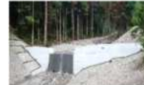
治山施設整備
