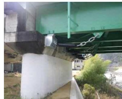
落橋防止の設置
