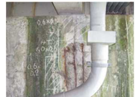
コンクリートの剥離(橋脚)の補修
