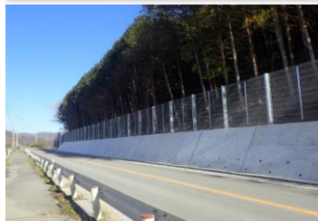
国道373号 落石防護柵(上郡町)
