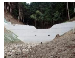
治山ダムの整備
