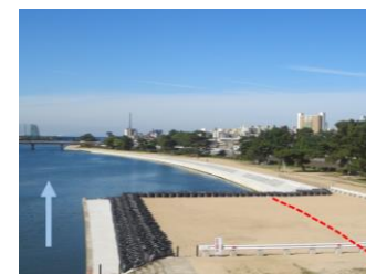
武庫川 河川改修
