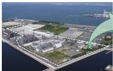
兵庫東流域下水汚泥広域処理場
