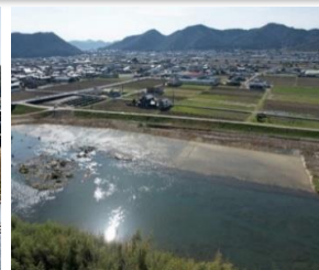
加古川 河床掘削(西脇市)
