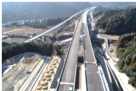
▲ 亀山西JCT(工事当時に撮影)
