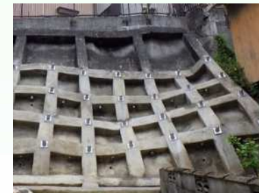
施工前 急傾斜地崩壊対策の事例 施工後
