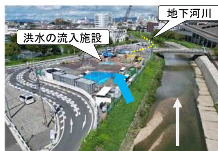
河川海岸整備
