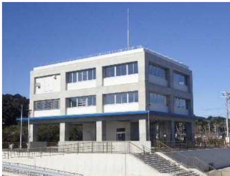
県有建築物のZEB化
