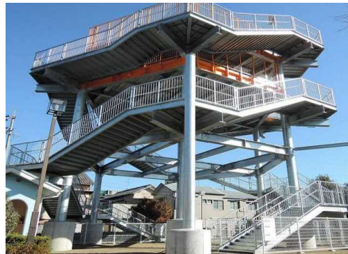
津波避難タワー（焼津市）
