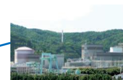
日本原子力発電(株) 敦賀発電所
