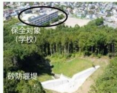
砂防関係施設整備
