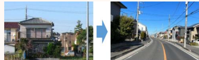
土地区画整理事業により整備された都市計画道路
