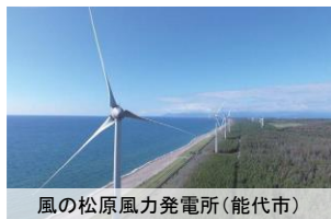
風の松原風力発電所(能代市)
