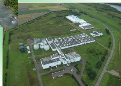
石狩川流域下水道 奈井江浄化センター
