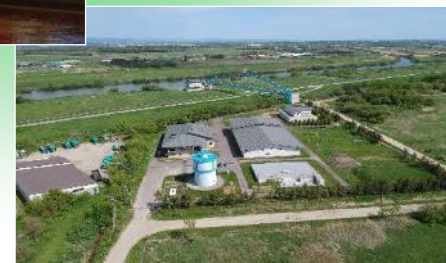
石狩湾新港地域工業用水道中沼浄水場
