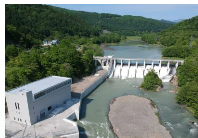
清水沢発電所
