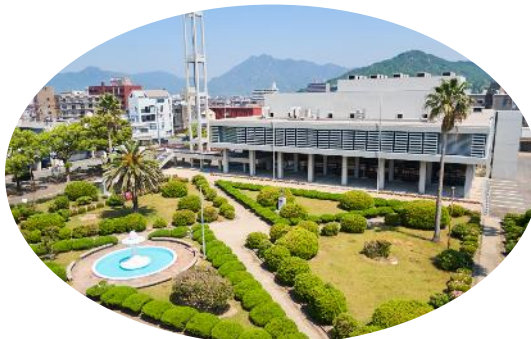
防府市公会堂（山口県防府市）
