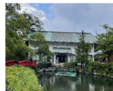
改修予定の旧文化財資料館
