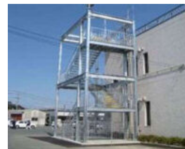
津波避難ビルの外階段設置
