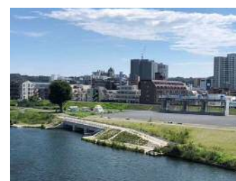
▲建設工事写真（放流部）
