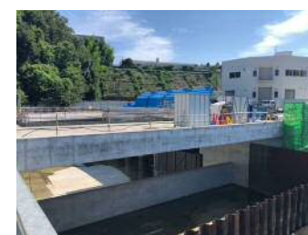
▲建設工事写真（分流部）
