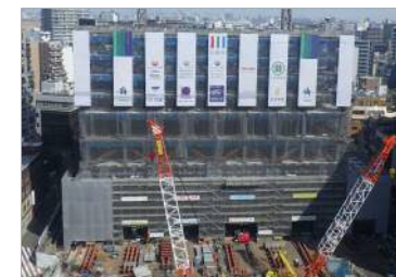
▲建設工事写真
