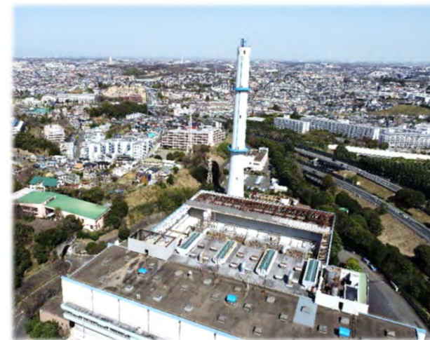
ごみ焼却工場（保土ヶ谷工場）
