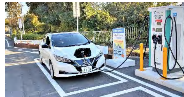
公道充電ステーション(青葉区)
