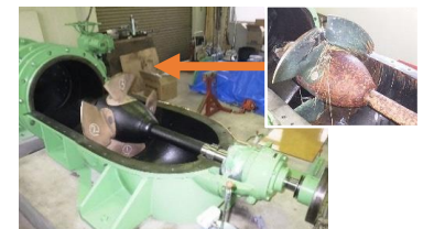
ポンプ設備の補修
