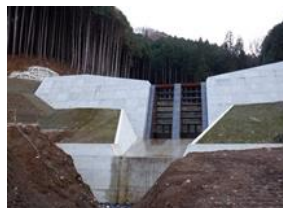
砂防施設整備
