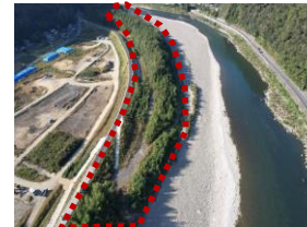
河道掘削・堤防整備
