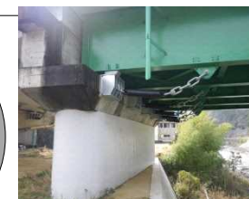
橋梁耐震化 落橋防止の設置
