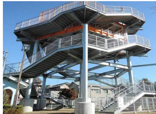
津波避難タワー（焼津市）
