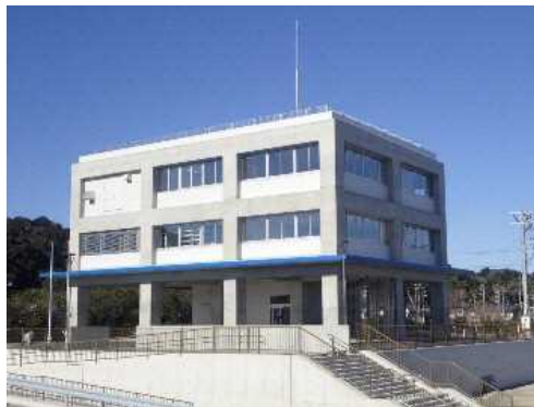
県有建築物のZEB化
