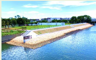
防潮堤・水門等整備
