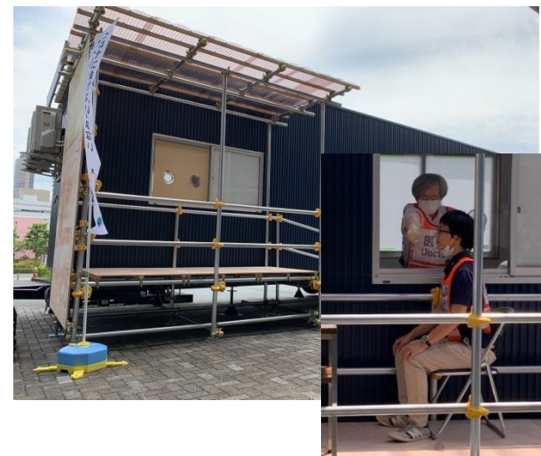
トレーラーハウスを活用した ウォークスルー方式の PCR検査センター
