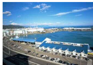
江尻港(河岸の市)の現況
