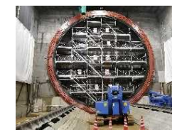
札幌トンネル(札幌工区)
