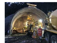
札幌トンネル(富丘工区)
