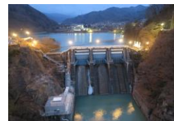
長野県宮高遠さくら発電所
