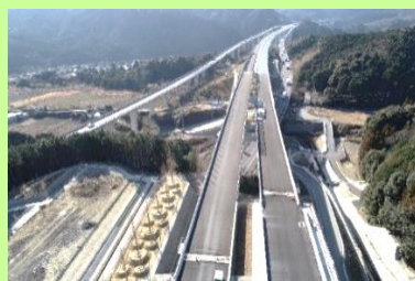
▲ 亀山西JCT（工事当時に撮影）
