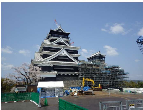
2020年3月31日 外観復旧した大天守
