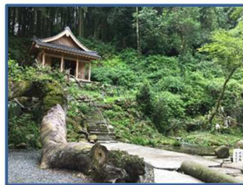
益城町：潮井神社（震災遺構）
