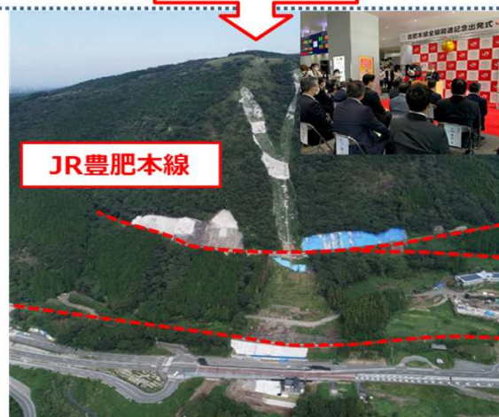
県斜面对策工事 (治山)
