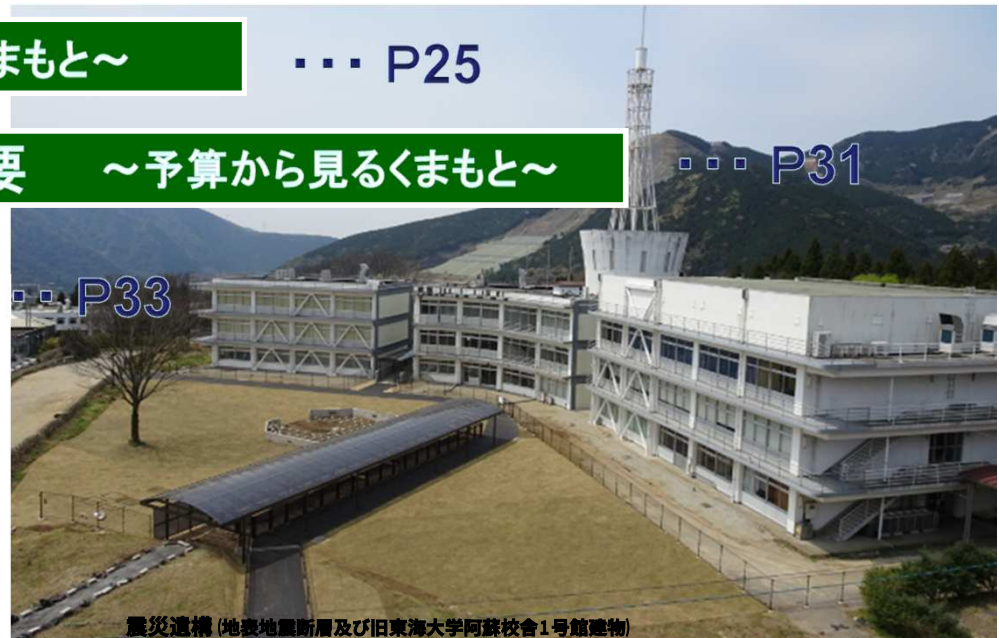
震災遺構 (地表地震断層及び旧東海大学阿蘇校舎1号館建物)
