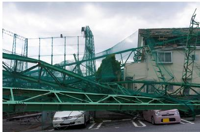
ゴルフ練習場の鉄柱倒壊(市原市)
