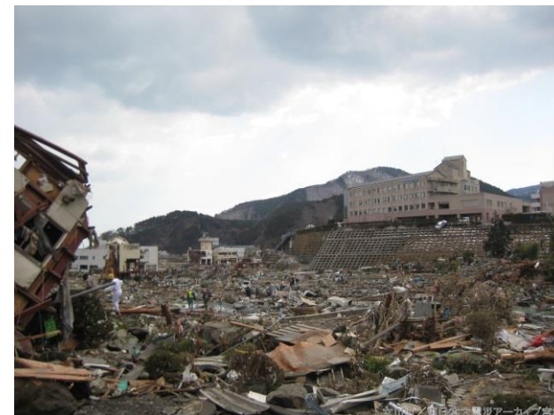
女川町の被害状況
