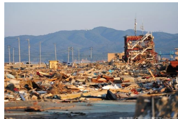
南三陸町の被害状況
