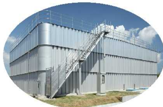
金田配水場（千葉県木更津市）
