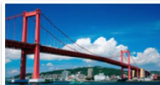
若松と戸畑を結ぶ若戸大橋
