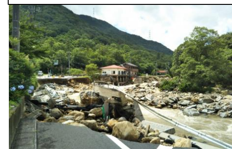
関川(安佐北区)護岸崩壊
