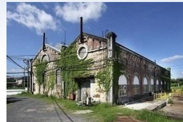
遠賀川水源地ポンプ室
