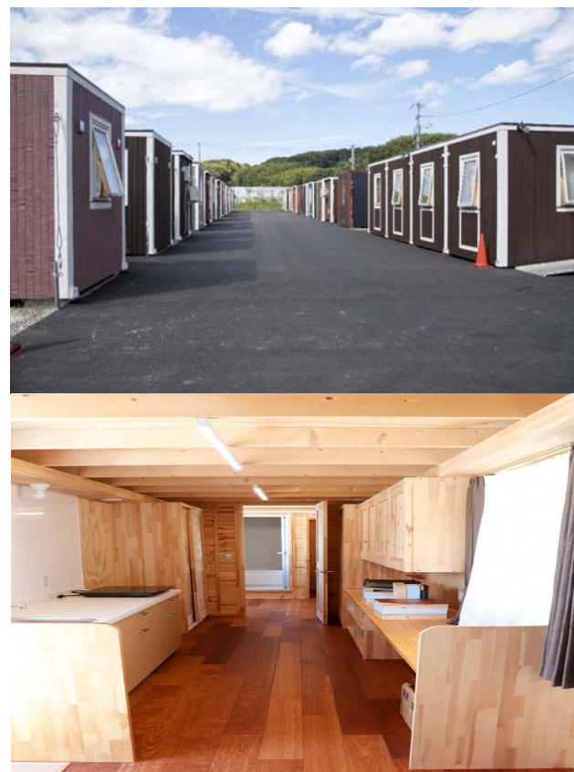
柳井原仮設住宅（倉敷市）
