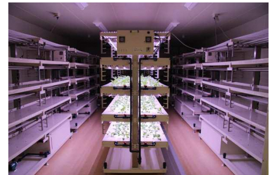
AOI-PARC（東海大学旧校舎（沼津市）改修）
